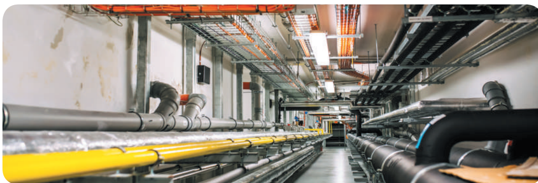
Технічний поверх багатоповерхівки
